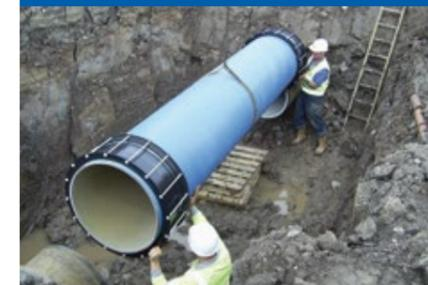
Raccord réduit MaxiStep DN700
