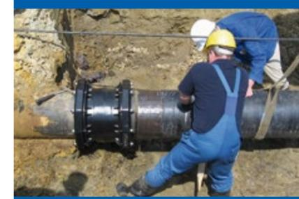
Raccord UltraGrip de nouvelle génération DN400
